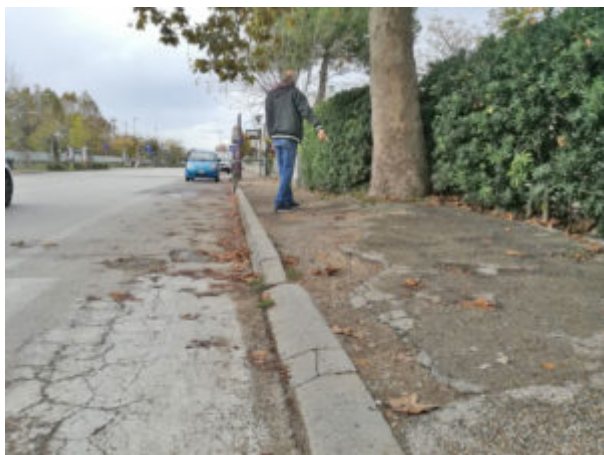
stazione lato mare
