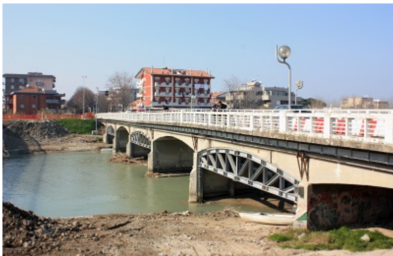
Il ponte che verrà abbattuto (foto M.NICOLETTI)
